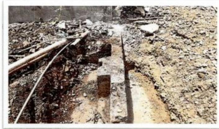
*Foto de la zapata de la columna eliminada del lado del escenario.
